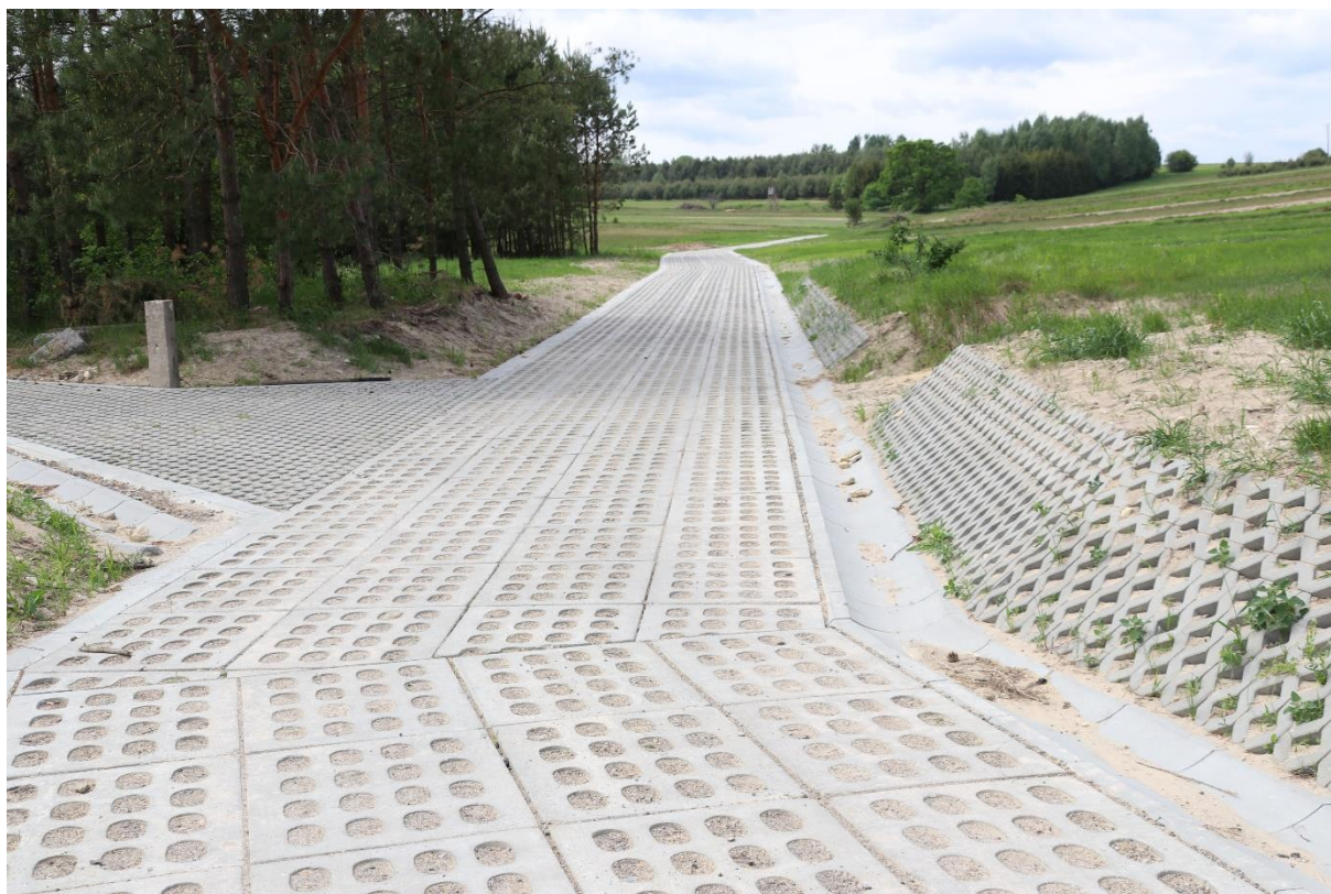
Remont drogi w Obroczy
