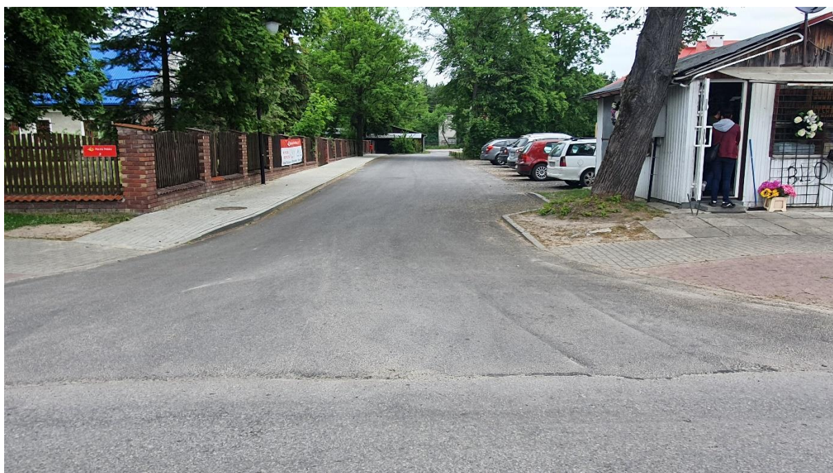
Remont drogi koło poczty.
