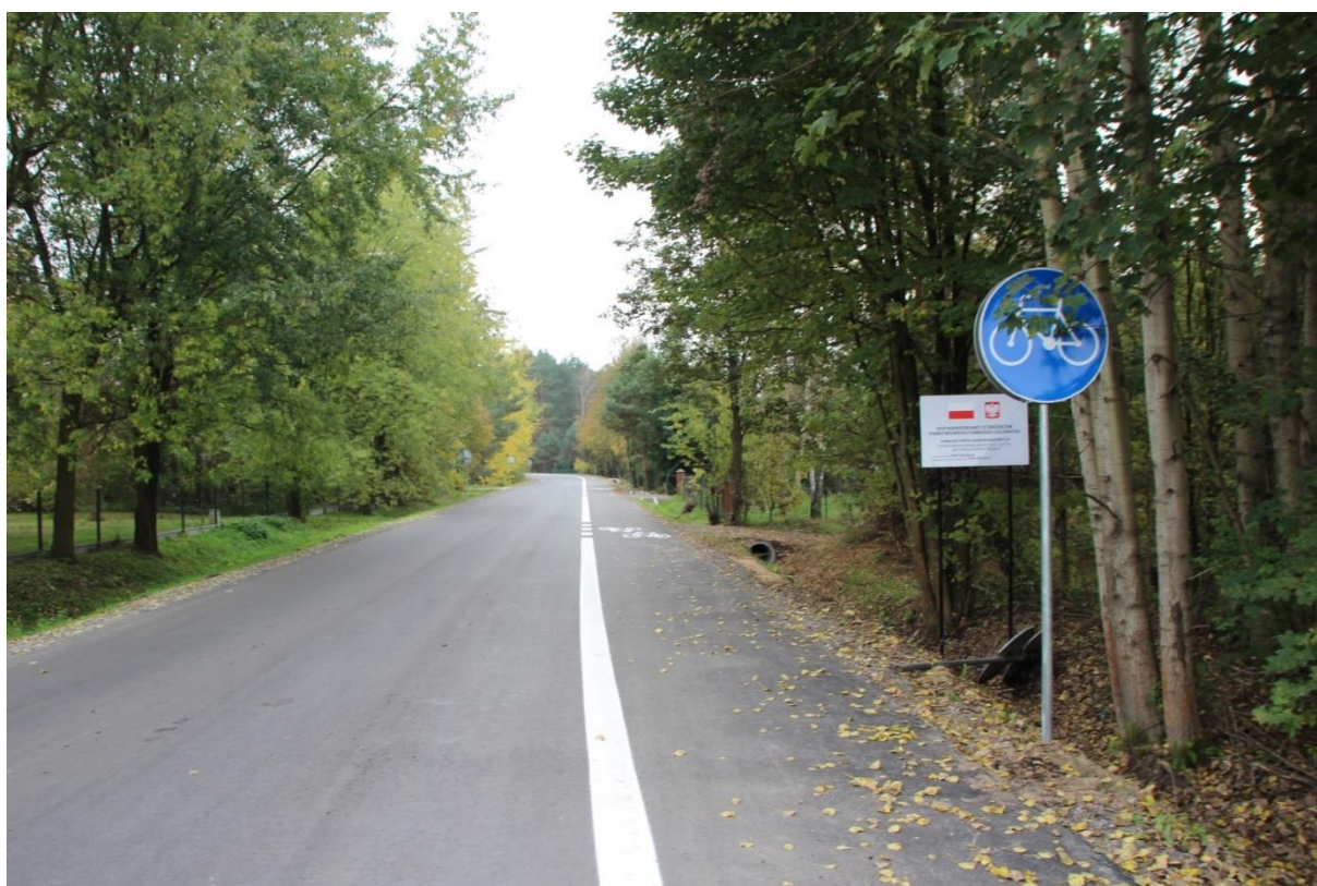
Przebudowa drogi gminnej nr 110776 L do miejscowości Bagno
