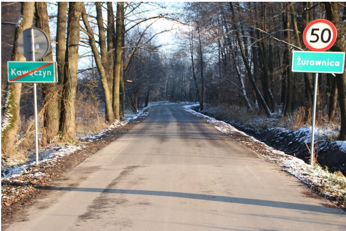
Przebudowa drogi gminnej Nr 116627 L w miejscowości Żurawnica.
