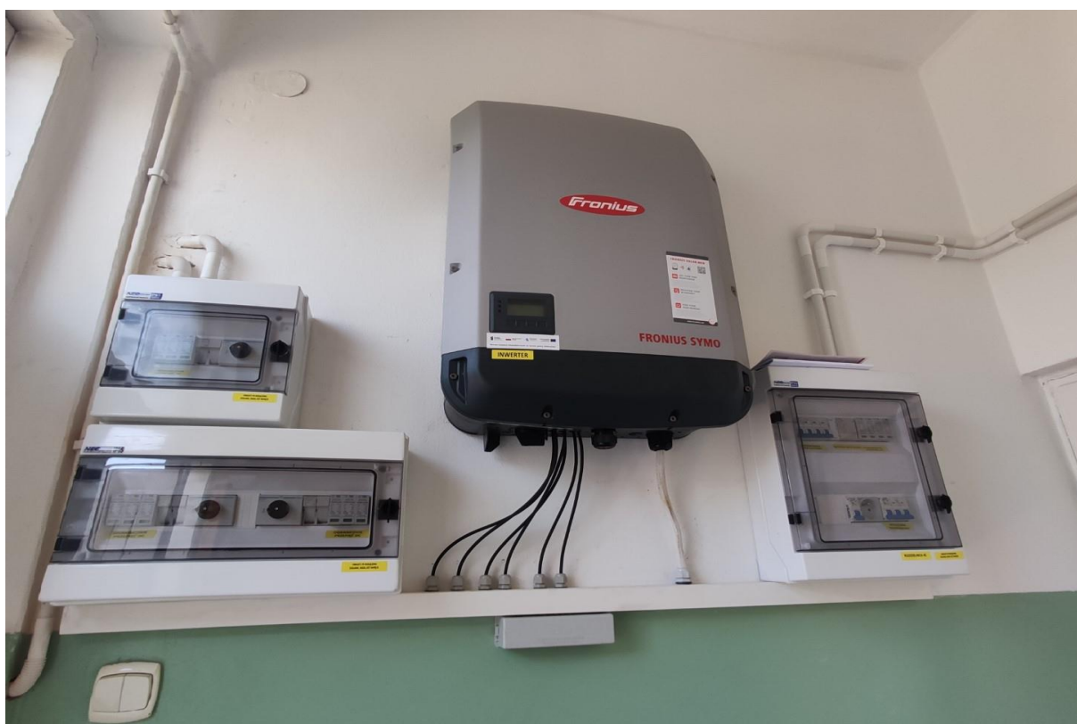
Montaż instalacji fotowoltaicznych na terenie Gminy Zwierzyniec.
